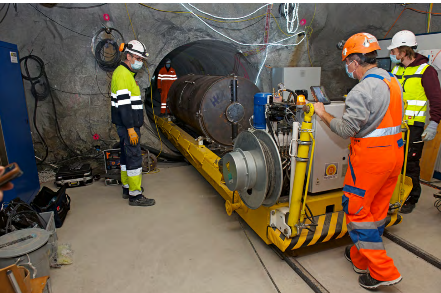
Arbeiten im Felslabor Mont Terri. Foto: Nagra
